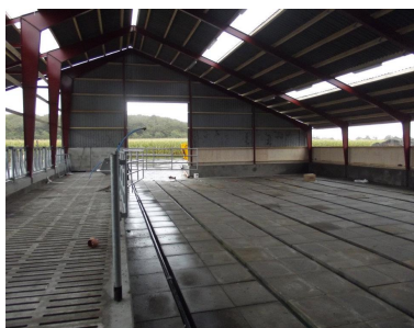
Nyetableret bund med slanger til beluftning. Slangerne er anbragt imellem rækker med to stk. 60x60 cm fliser, som beskytter slangerne mod skader ved fræsning og grubning.
